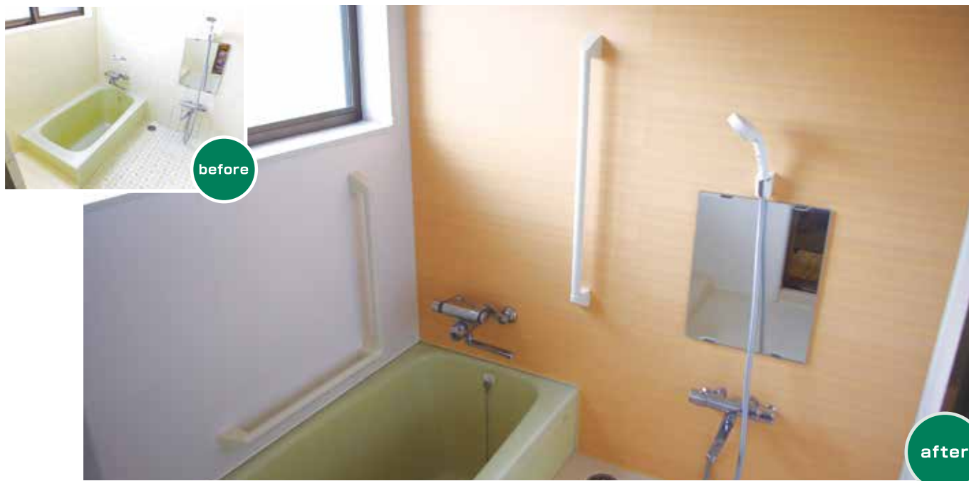
施工例 手すり：左面L型600、右面I型800 壁面：アルパレージ 左面 NC 、右面 TK 床面：あんから V
