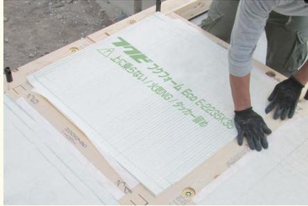
根太無し工法用の場合、フクフォームEcoの中央部が大引と面になるように充填します。
