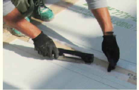
タッカーは片側3箇所以上としてください。また、タッカーのピッチは300mm以内としてください。タッカーを打つ場合は製品と平行になるように打ちつけてください。
