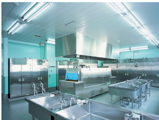
物件名/ 小学校 使用場所/ 給食室 天井
