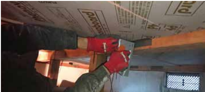
アンクルの位置はフェノバボードが落下しない位置に固定してください。
