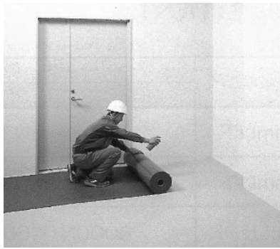
写真:接着剤散布時
