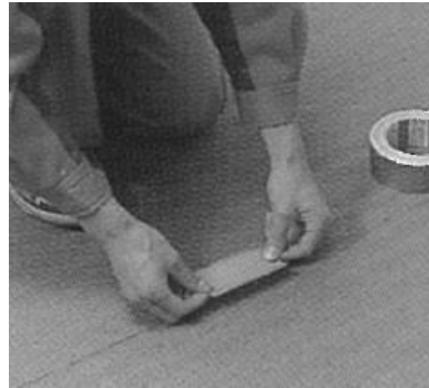
写真:テープ貼付け時
