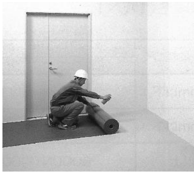
写真:接着剤散布時
