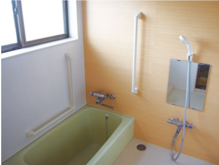
施工例 手すり 左面 L型600、右面 I型 800 壁面 アルバレージ 左面 [NC]、右面 [TK] 床面 あんから [V]
