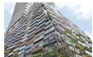
豊島区新庁舎 デッキ・ルーバー 東京都豊島区 2015年
